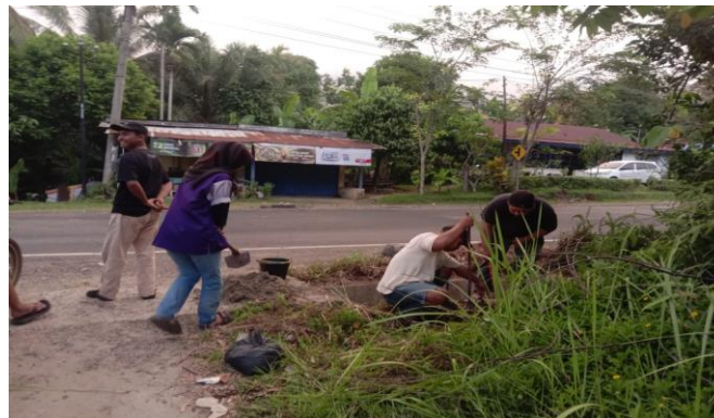
Gambar 3. Proses Pemasangan Plang dengan barcode
